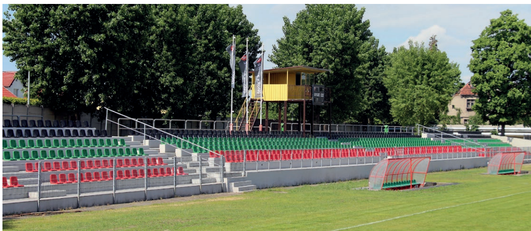
Stadion Promień - remont fundamentów trybun, wymiana krzesełek, nowe miejsca dla piłkarzy rezerwowych, wyremontowany ciąg pieszy - koszt 538 tysięcy złotych. Odbudowa głównej drogi dojazdowej na boisko piłkarskie - koszt 55 tysięcy złotych.
