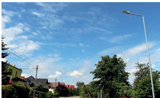
Budowa oświetlenia na ul. Śląskiej - odcinek od ul. Smoczyka do Al. Wojska Polskiego. Koszt ponad 91 tysięcy złotych.
