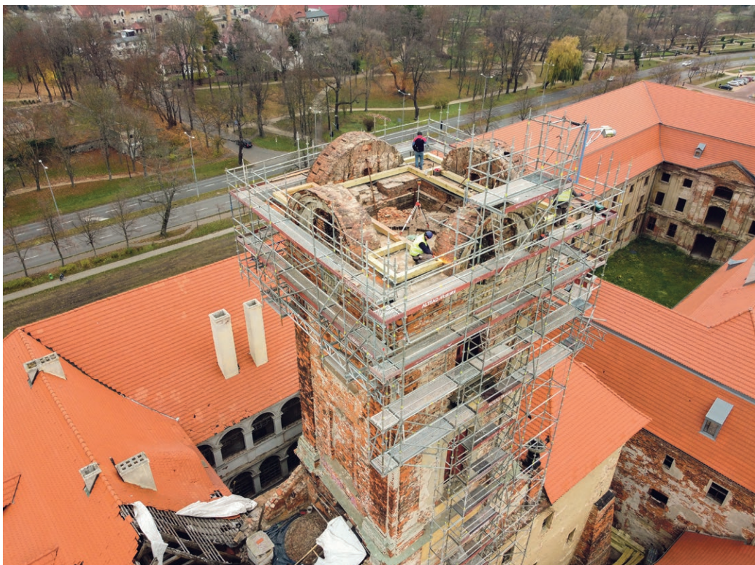
Prace budowlane w celu odbudowy hełmu wieży zamkowej
