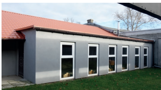
Remont elewacji i montaż dodatkowego kulochwyty na obiekcie STRZELNICA
