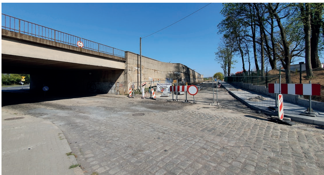
Remont ulicy Kujawskiej
