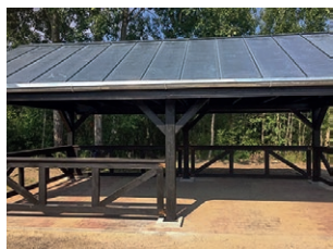
Budowa wiaty pomiędzy stawami Kwadrat i Przeprawowy działka nr 372
