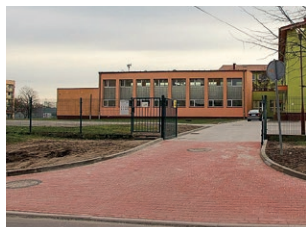
Wykonanie parkingu i wjazdu od ul. Szymanowskiego w Żarach do Szkoły Podstawowej nr 1
