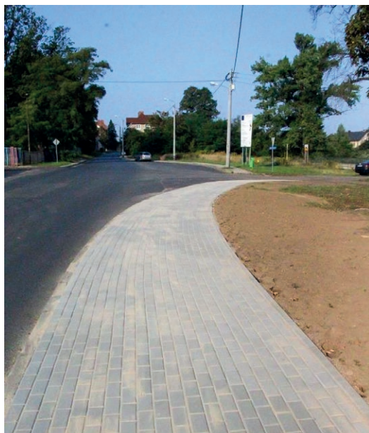
Przebudowany chodnik, ul. Witosa
