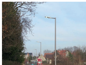
Oświetlenie drogi 2-3 lampy - droga łącząca Al. Wojska Polskiego od przystanków z ul. Lelewela
