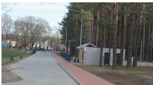
Dodatkowe oświetlenie ciągu pieszych na obiekcie SYRENA
