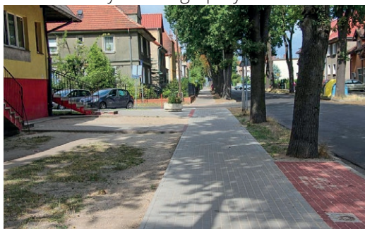
Remont chodnika, ul. Katowicka
