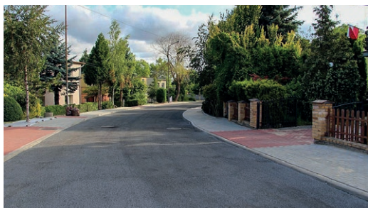
Wykonane zostały chodniki po obu stronach jezdni, ul. Reymonta
