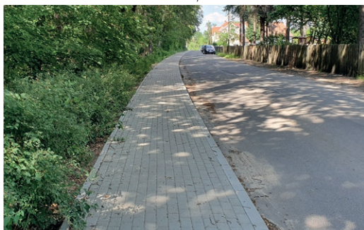
Przebudowa chodnika, ul. Westerplatte
