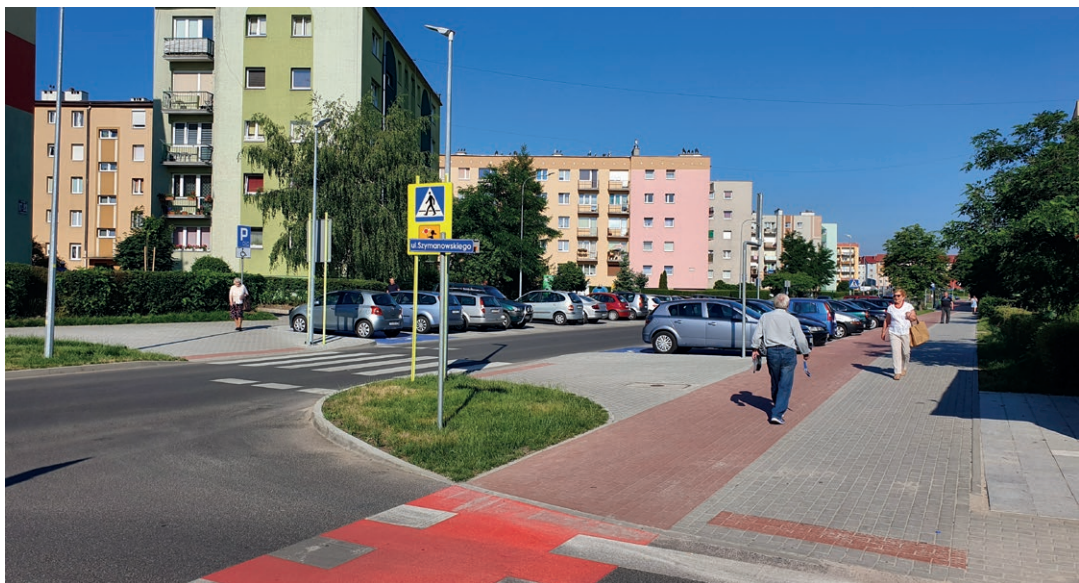
Przebudowa ul. Wieniawskiego
