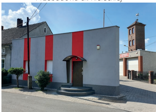
Modernizacja świetlicy OSP Żaty-Kunice
