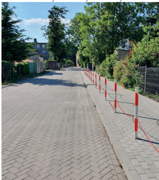
Remont chodnika, ul. Broni Pancernej
