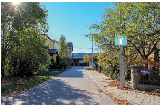
Przebudowa ul. Kieleckiej
