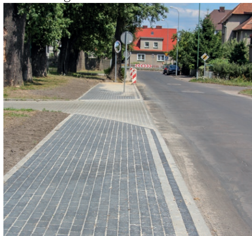
Remont chodnika, ul. Paderewskiego
