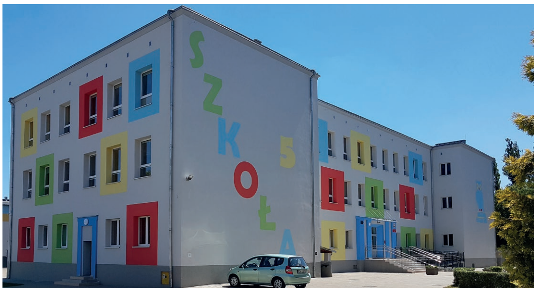
Termomodernizacja Szkoły Podstawowej Nr 5
