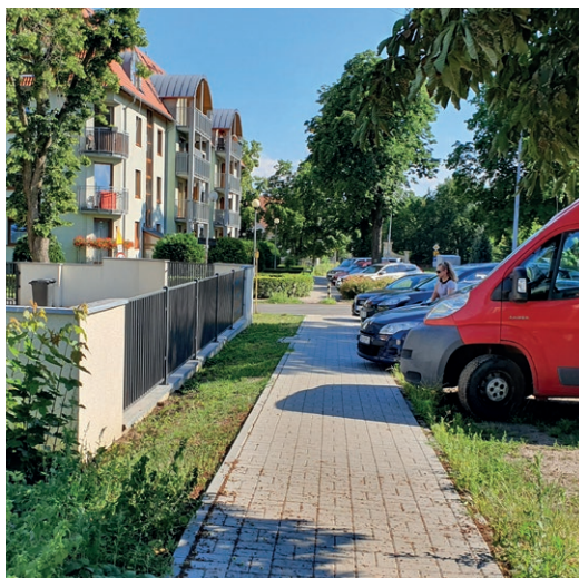
Budowa chodnika, ul. Poznańska
