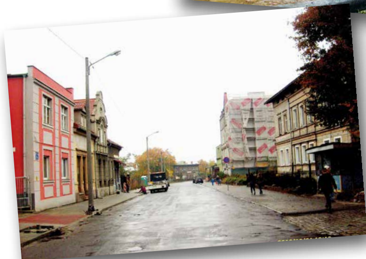
Remont chodników i wymiana oświetlenia przy ul. Okrzei
