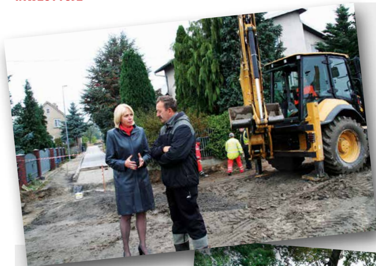
Trwa przebudowa drogi przy ul. Pułaskiego
