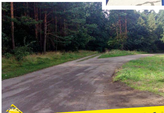
Utwardzenie drogi gruntowej ul. Leśna w kierunku ul. Komuny Paryskiej
