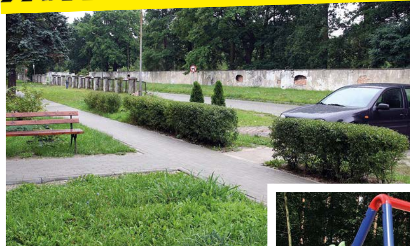
Remont chodników - ul. Zawiszy Czarnego
