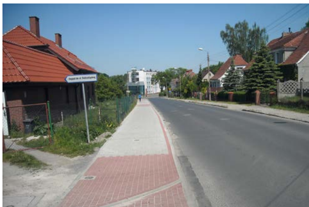
ULICA KASZUBSKA- MODERNIZACJA CHODNIKA
