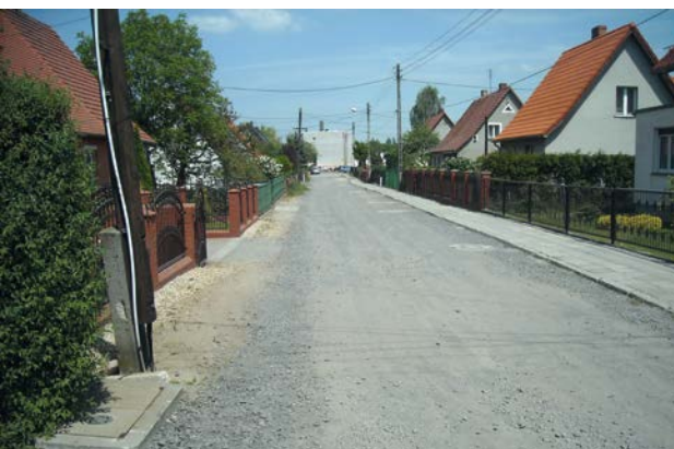
PRZEKAZANO PŁAC BUDOWY NA ULICACH KONARSKIEGO- STEFICYKA. INWESTYCJA POLEGAĆ BĘDZIE NA PRZEBUDOWIE DRÓG WRAZ Z INFRASTRUKTURĄ TECHNICZNĄ. PLANOWANY TERMIN ZAKOŃCZENIA PRAC- PAŹDZIERNIK 2016R.
