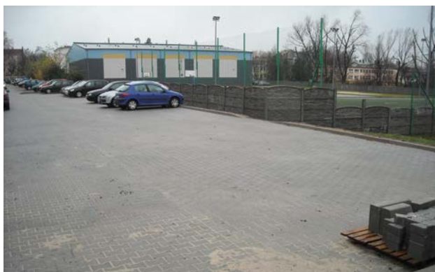
Utwardzenie terenu przy Zespole Szkolno - Przedszkolnym z oddziałami integracyjnymi na ul. 9 Maja.
