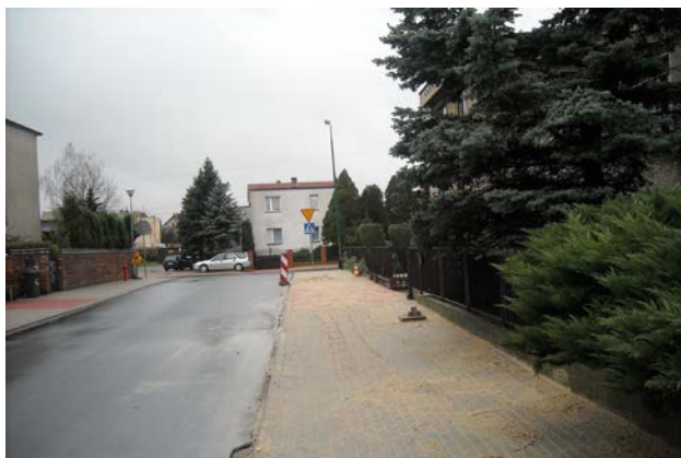
Remont chodnika po prawej stronie na ul. Kasprzaka.
