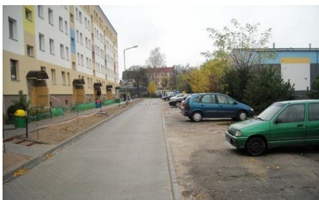
Remont ul. Katowickiej przy bloku nr 2.
